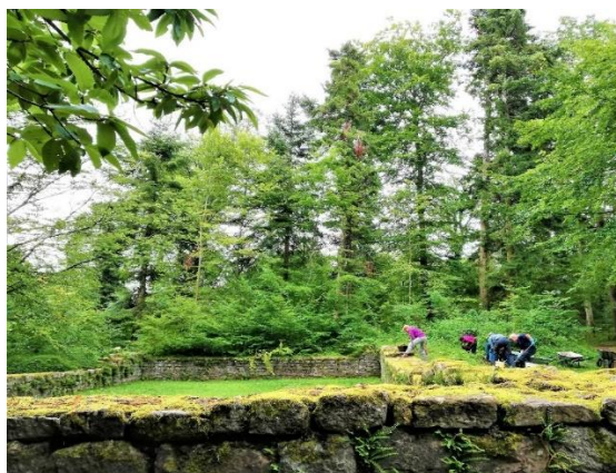
9. Eglise de Schwarzenenthann toujours en chantier.
